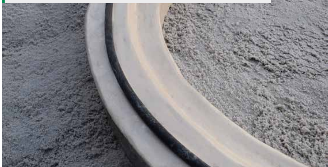
Rehausse traitée avec Epolith.
